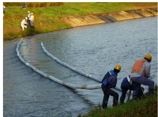
☆ 川にオイルフェンスを設置 ☆
