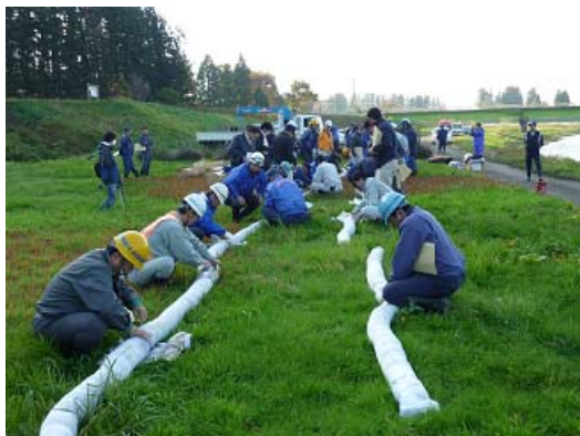
☆ オイルフェンスを接続 ☆
